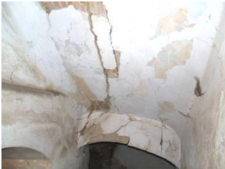
Trhliny v klenbě a klenebném pasu schodiště
